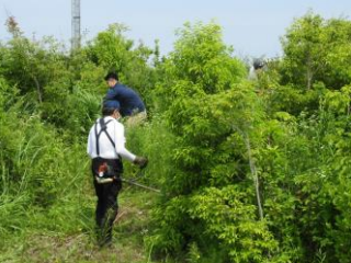
園路法面の除草作業を行いました。
